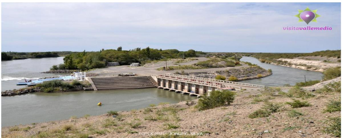
La Boca-Toma está ubicada fuera de la isla de Choele Choel, a unos pocos kilómetros de la misma esta la obra del Partidor donde nace el canal principal en su recorrido ingresa a la isla de Choele Choel, por medio de un sifón que pasa debajo del lecho del río en el brazo sur de la isla a escasos 100 metros de la Bocatoma del canal de los Galeeses, lugar donde en 1902 se iniciaron los trabajos para la construcción del canal galés.
