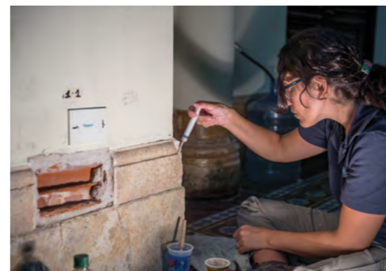
EPÍGRAFE - (Pág. 60) Relevamiento y decapado de zócalos de material cementicio. (Pág. 61) 1. Zócalo de material cementicio con deterioros visibles. 2. Consolidación de zócalos de mármol por inyección.
