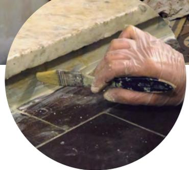
En los zócalos de mármol se realizaron retoques de color con pinturas al látex y entonadores al agua en las superficies intervenidas.
