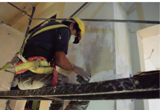
El perfil de la viga longitudinal al pasillo presentaba irregularidades en la superficie. Se encontraron además clavos deformados y fijados al muro cuya función, presumiblemente, fue de sostén de cables eléctricos. Una vez eliminados y retirados éstos, se procedió a la consolidación e integración volumétrica.
