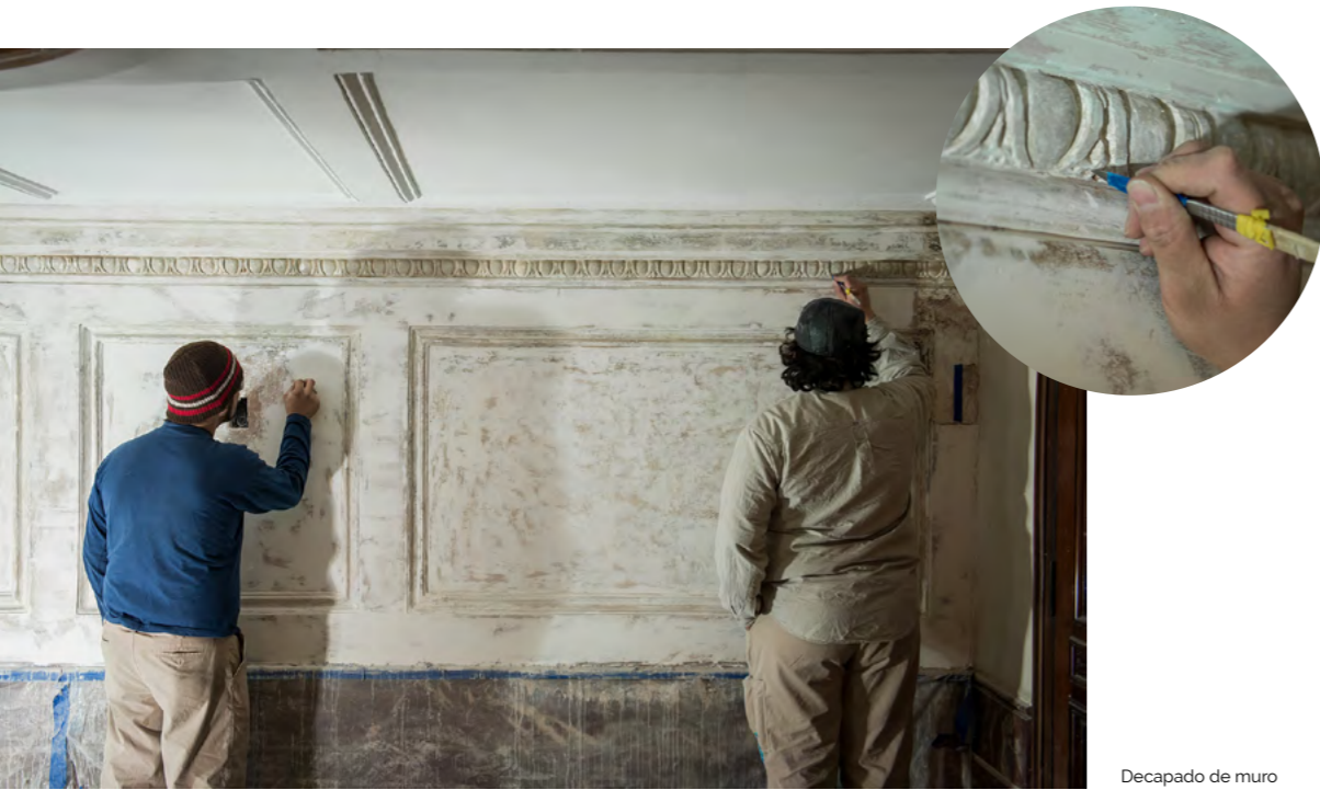
Decapado de muro
