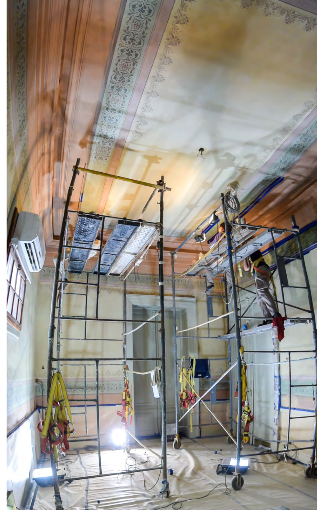
Vista de la oficina durante el proceso de intervención.
