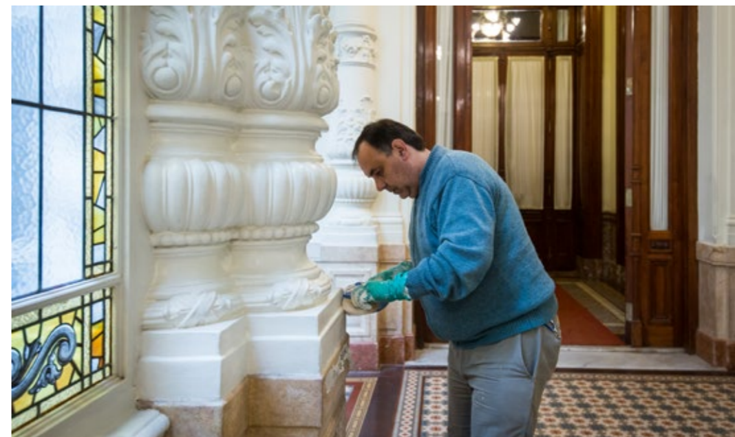
Retoque de pintura en columnas del pasillo.
