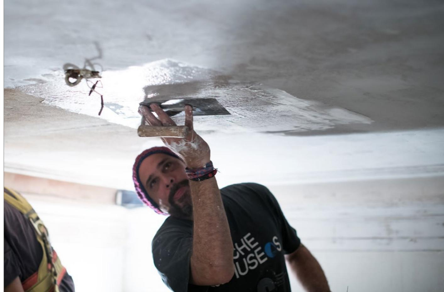
En el sector en el que se encontraban los caños metálicos se removió el revoque grueso disgregado hasta un estrato firme para proceder a consolidar el muro con un mortero fluído consolidante. La caja de electricidad se aseguró con la colocación de mortero y las tuberías recibieron un tratamiento específico para facilitar una posible intervención a realizar en el futuro.
