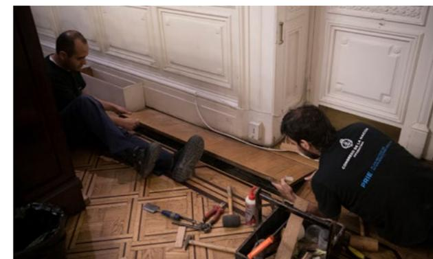
En la *Sala del Despacho del Presidente* se intervino el solado como parte de la readecuación del sistema eléctrico ubicado por debajo de la guarda perimetral. Los paneles que guardan el cableado están obrados en madera, fenólico o aglomerado.
