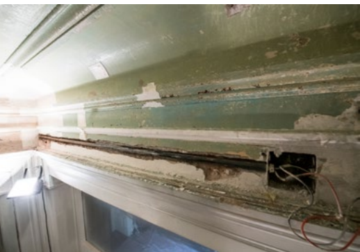
Muros y cielorraso del hall de acceso durante el proceso de decapado mecánico.
