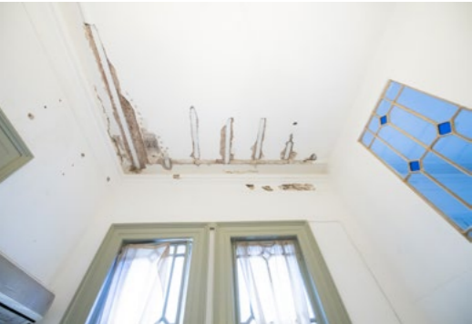
(Pág. 56) Vista del cielorraso con viguetas de hierro que integran la estructura de bovedilla.
