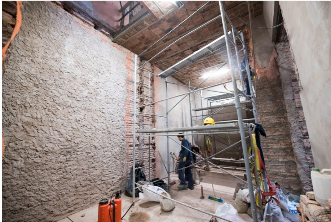
■ Muro desmantelado en primer piso.
