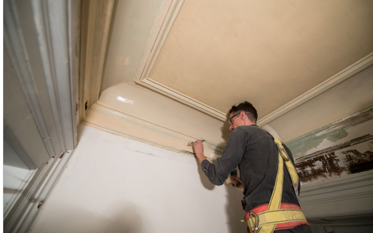
Aplicación de pintura en cielorraso y garganta del hall de acceso.
