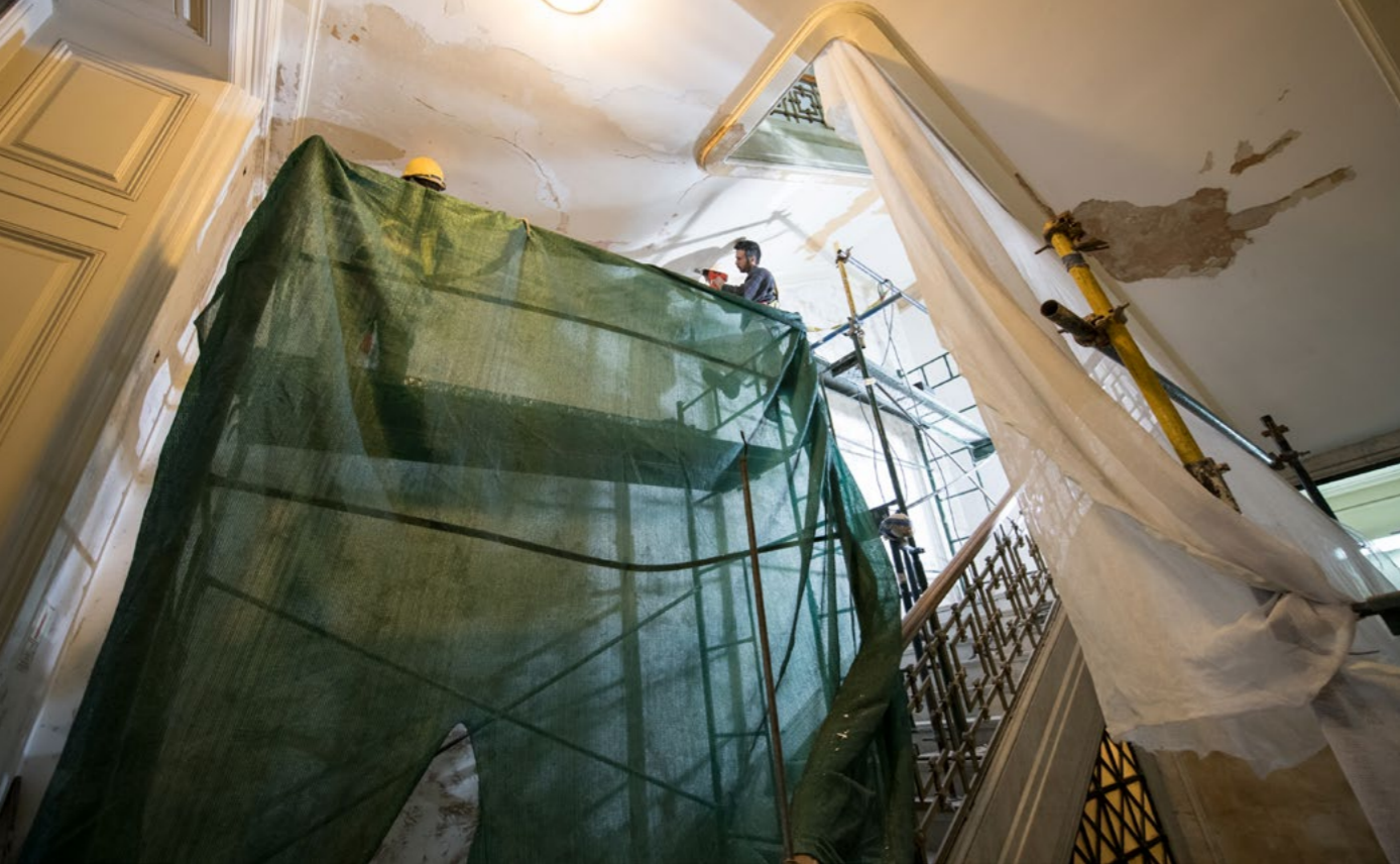
Intervención de muros y cielorrasos en los diferentes pisos de la escalera.
