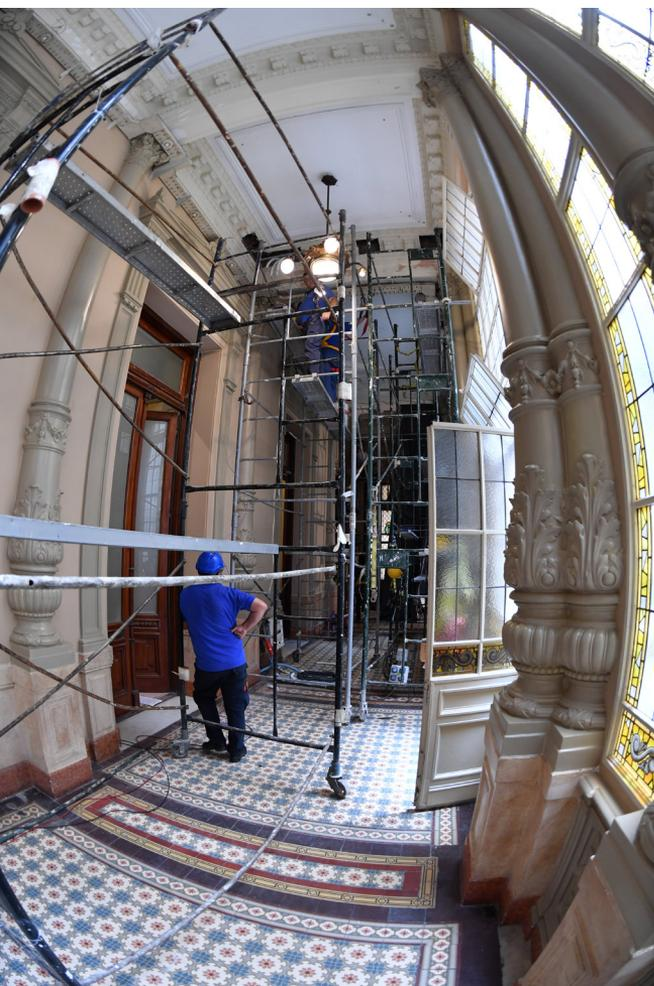
Se continuó con la ejecución de tareas de decapado y preparación de superficies, reemplazo de molduras y aplicación de pintura en los halls de planta baja y primer piso.
