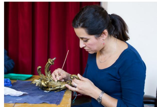
La intervención de esta luminaria comenzó con el desarmado de piezas –algunas de las cuales se encontraban adheridas entre sí– y limpieza mecánica en seco y en húmedo de la superficie metálica. Se removieron restos de adhesivo y productos de corrosión del cobre.
