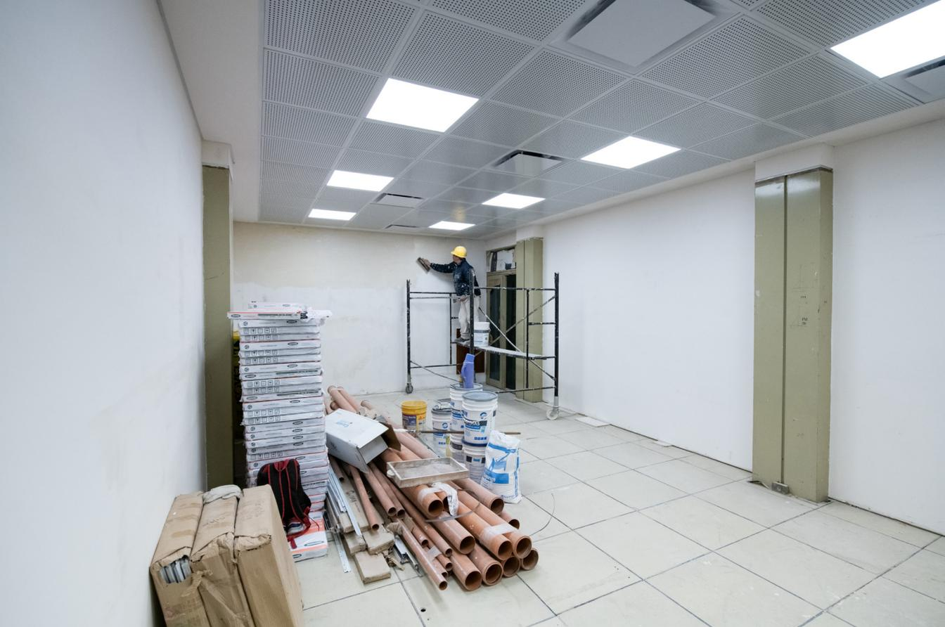
En las dos oficinas de los subdirectores, en la planta baja, se instaló una tabiquería divisoria de placa cementicia, se reparó una pared y se instaló el piso técnico.
