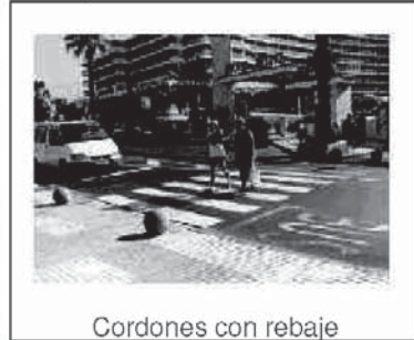
Cordones con rebaje
