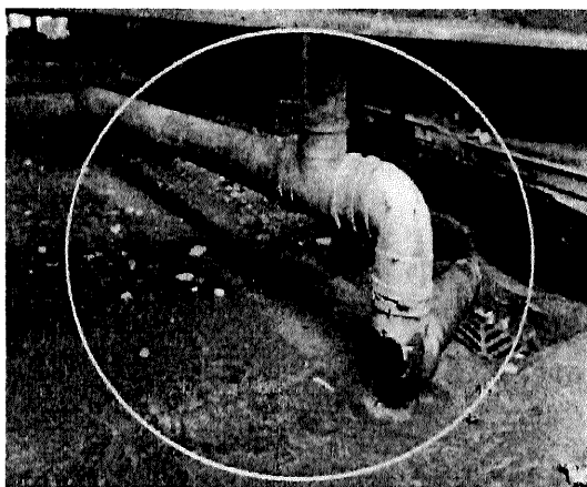
Caño de 2" de desagote de una torre hacia una rejilla próxima.
