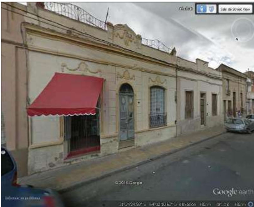
Conjunto esquina Chubut y Santa Rosa, frente al Hospital de Clínicas. Imagen: Google
