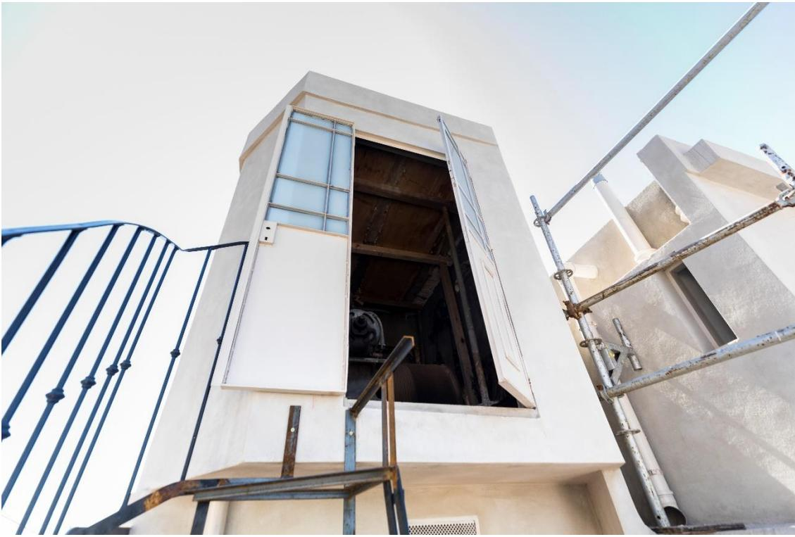
**Lucarna nivel terraza - piso 6° Derivación caños de ventilación hacia lucarna central y reparación azotea**
