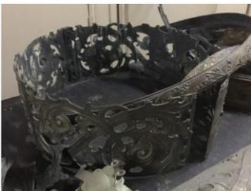
**8.1.2** Provisión y colocación de pieza **“ABRAZADERA ORNAMENTAL BASAMENTO”**, según las especificaciones detalladas en el ítem **“EJECUCIÓN DE LAS RÉPLICAS EN BRONCE”**. La Comisión Administradora del Edificio del Molino cuenta con piezas de esta tipología para efectuar las réplicas necesarias. **Cantidades detalladas en la planilla de cotización.**
